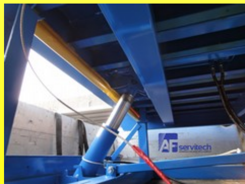
Sostituzione pistoni
