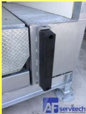
Sostituzione tamponi
